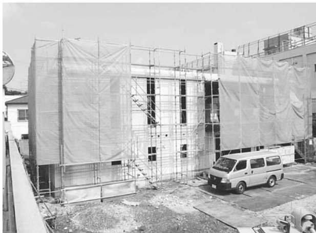
グループホーム虹の家「しおかぜ」の建設現場
